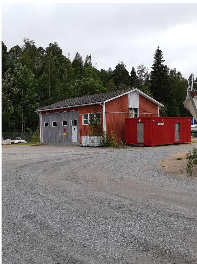
Kuva 4. Pelastuslaitoksen öljy- ja palotorjuntavarasto kesällä 2021.
